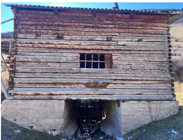
5-сурет – Судиірменнен 2,5 м биіктікте көлбеу орналасқан науа және оңтүстік жақтан қарағандағы ағып шығатын суға арналған тағандағы арнайы ойық (2024 жылы шілдеде автор түсірген)
