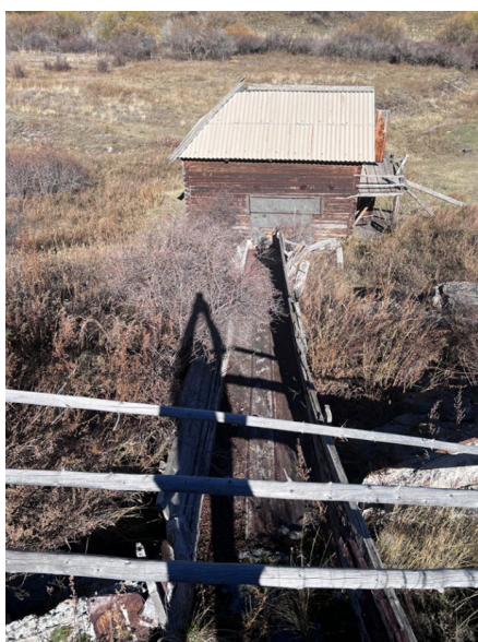
5-сурет – Судиірменнен 2,5 м биіктікте көлбеу орналасқан науа және оңтүстік жақтан қарағандағы ағып шығатын суға арналған тағандағы арнайы ойық (2024 жылы шілдеде автор түсірген)
