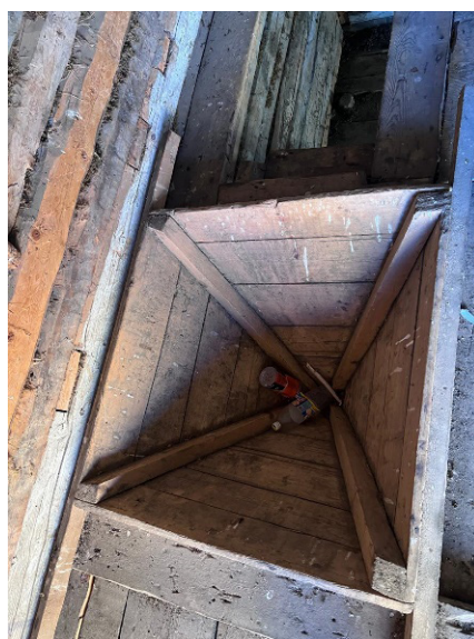
3-сурет – Судиірменнің үстіңгі тасы және тастың үстіне орналасқан астық науасы (2024 жылы шілдеде автор түсірген)
