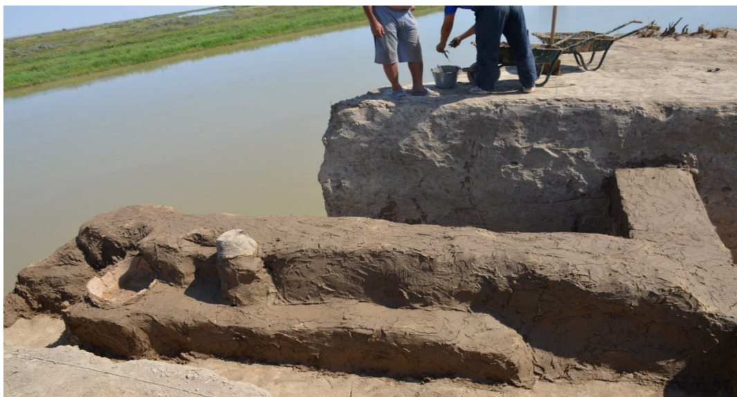
Рисунок 8 – Сортобе 1. Раскоп №1. Консервация выявленных строительных конструкций мокрой глиной вперемешку с саманом – высохшим камышом
